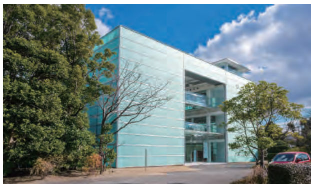
Pam（静岡県駿東郡）外観
